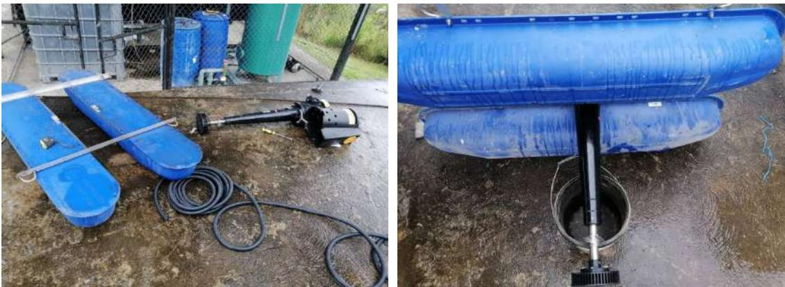
Se instaló el aireador en la piscina de lixiviados asegurándolo en sus cuatro lados con cadena y ganchos de ajuste rápido para una fácil y rápida manipulación. Estos accesorios son en material de acero inoxidable para evitar la corrosión por el contacto de líquidos.
